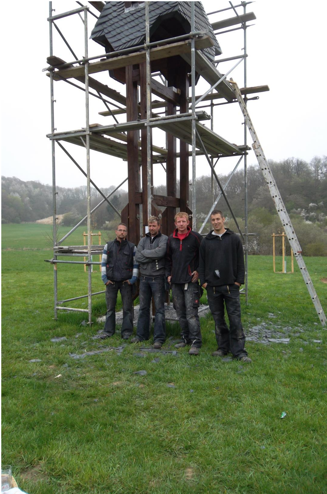
Die Dachdecker aus umliegenden Orten am 05. April 2014, nachdem das Dach mit Moselschiefer eingedeckt wurde.
