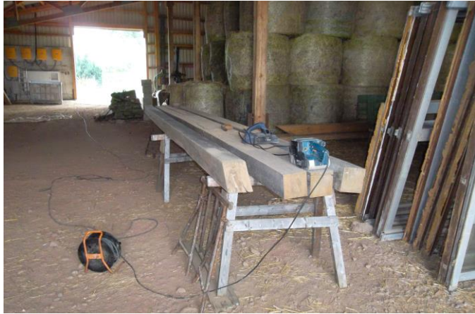
Hobel- und Schleifarbeiten
