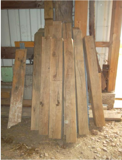
Zum Zusammenbau fertige Balken
