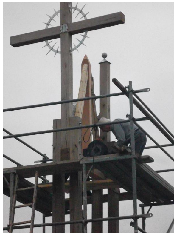
Gerd beim Bau der Dachkonstruktion
