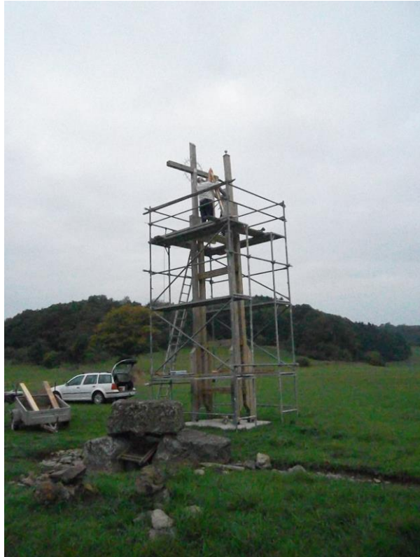
08.10.2013 Die Dachkonstruktion wird montiert
