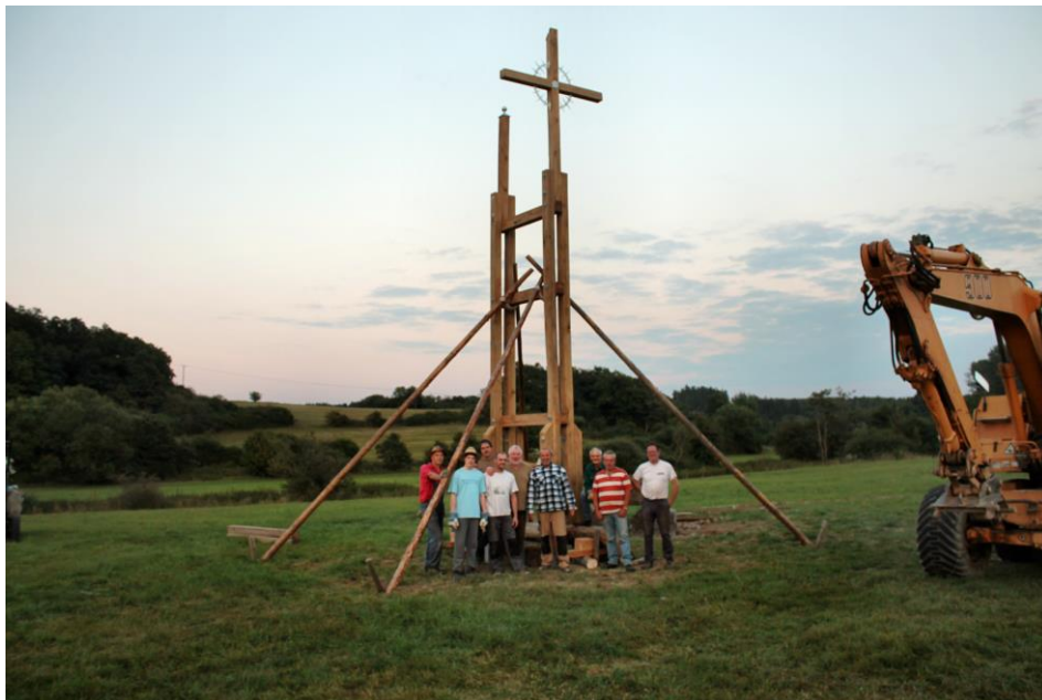
Endlich steht der „Rohbau“
